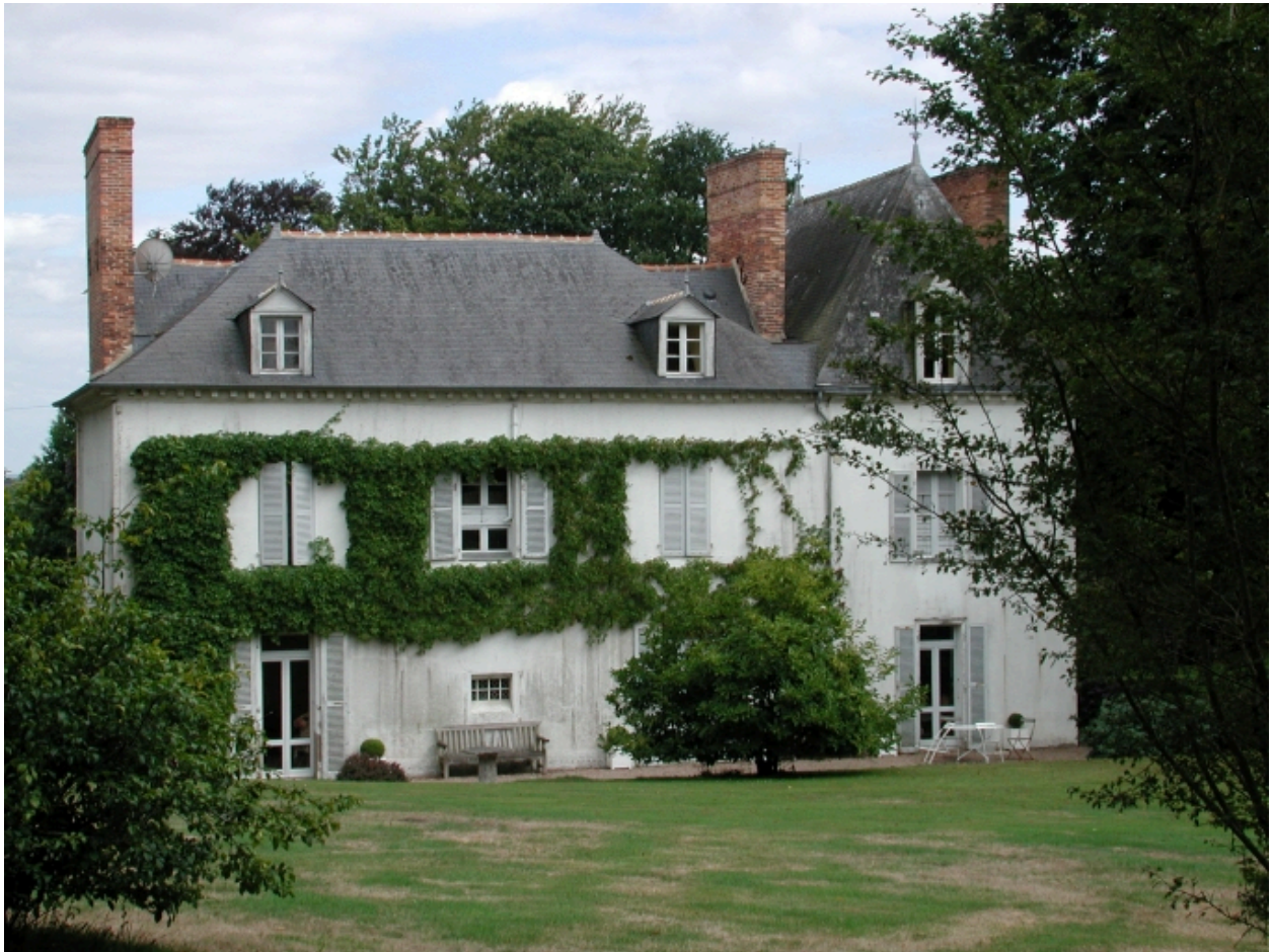
Façade nord du logis
