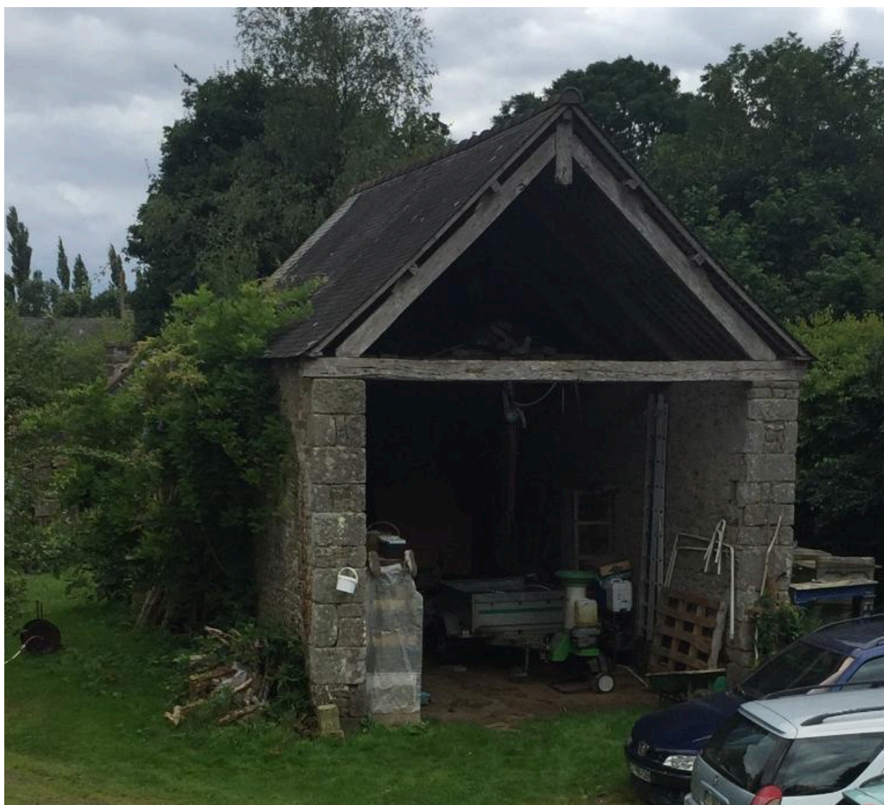
Remise, pignon nord
