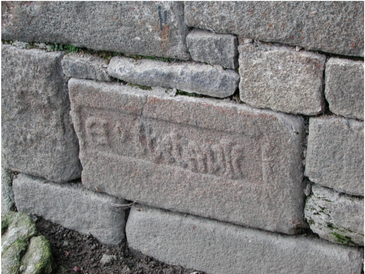
Mur de l'enclos ; pierre en remploi
