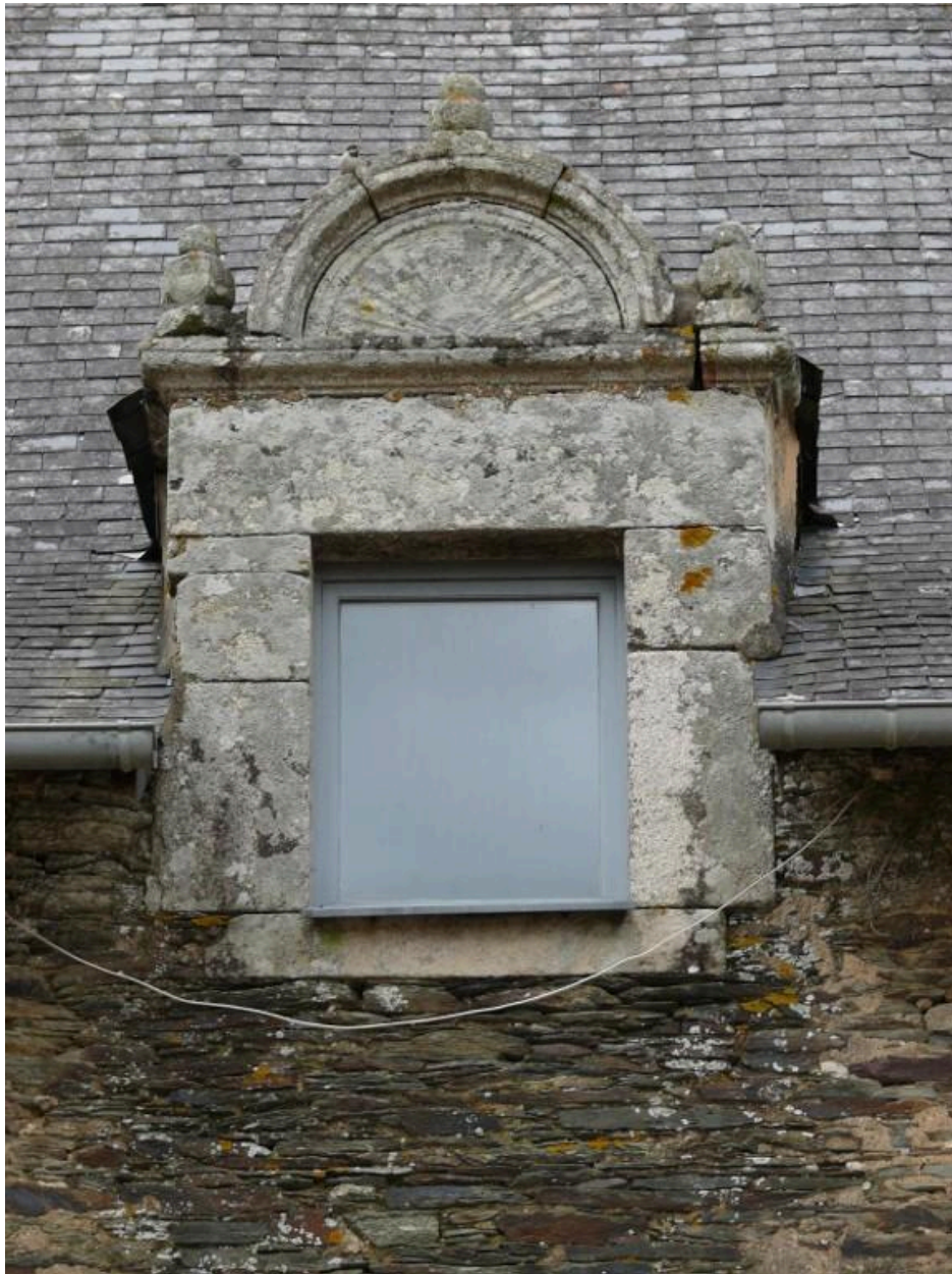
Lucarne Renaissance, façade sud, détail
