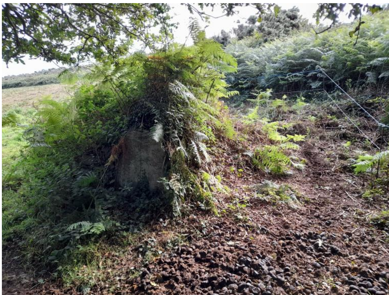
Mur 8, pierre dressée. Ancienne brèche.
