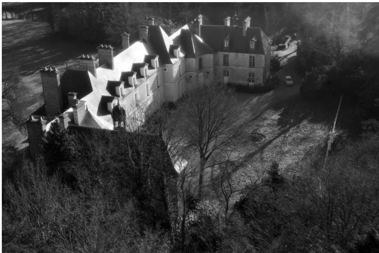
Vue aérienne vers le sud.
