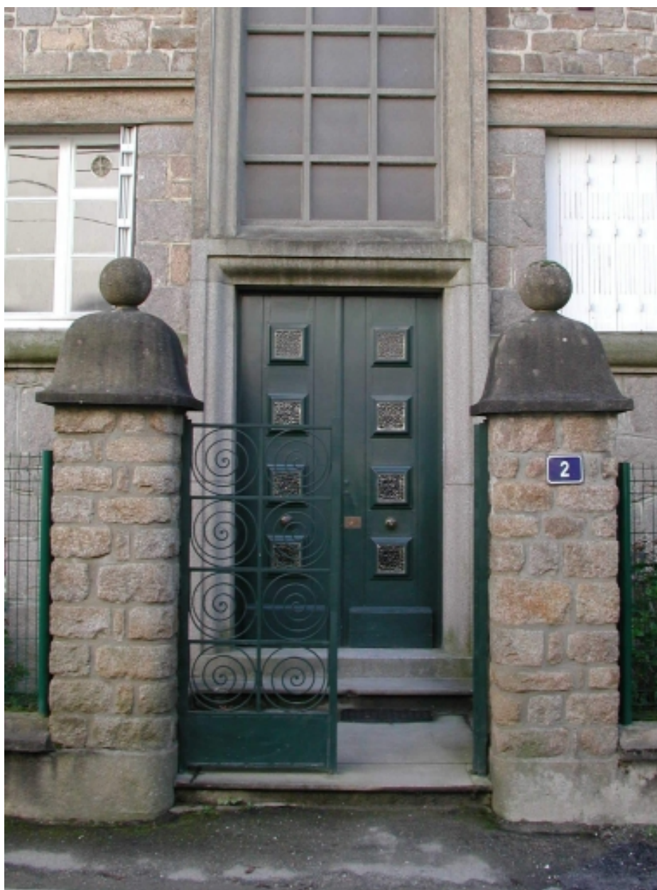
Vue de détail sur la porte d'entrée.
