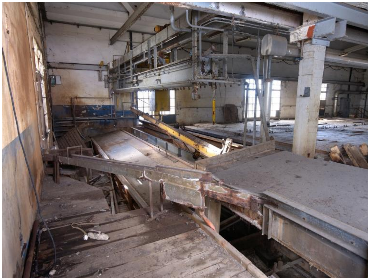
Frigorifique de Lorient : 4e étage, générateurs à glace et rampe vers niveau inférieur
