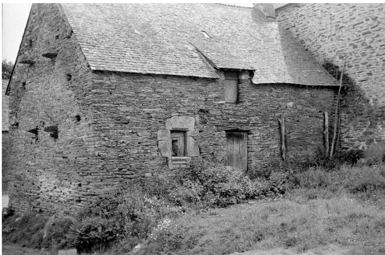
Ferme 23 (état en 1969)
