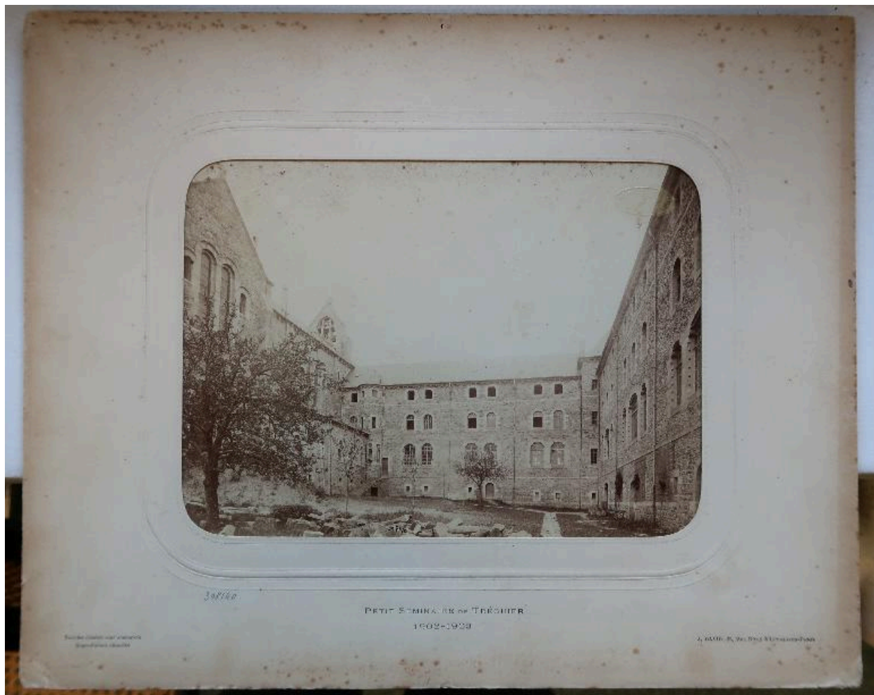
Tréguier : petit séminaire, vue générale des bâtiments encadrant la cour nord, vers 1902-1903 (Collection de la bibliothèque du collège Saint-Joseph de Lannion)
