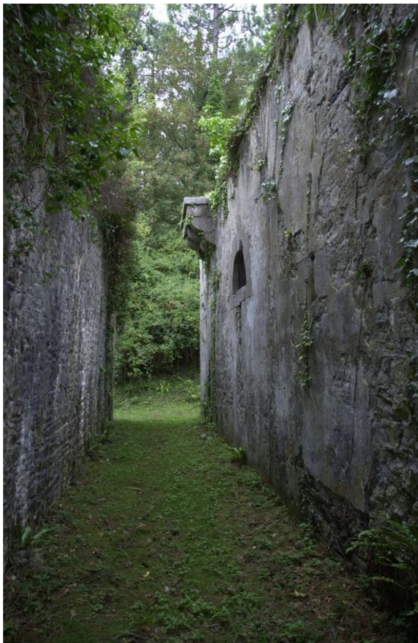
Vue du corps de garde crénelé n° 2 modifié de la pointe de Morgat ou Kador : façade sud protégée par un masque artificiel réalisé avec le déblai provenant de la fouille maintenue par une contrescarpe
