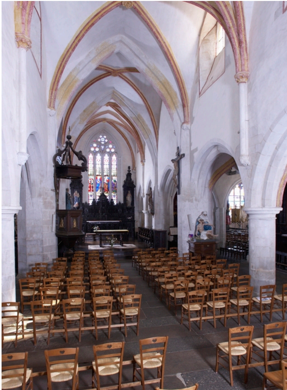
Nef. Vue générale intérieure vers l'est
