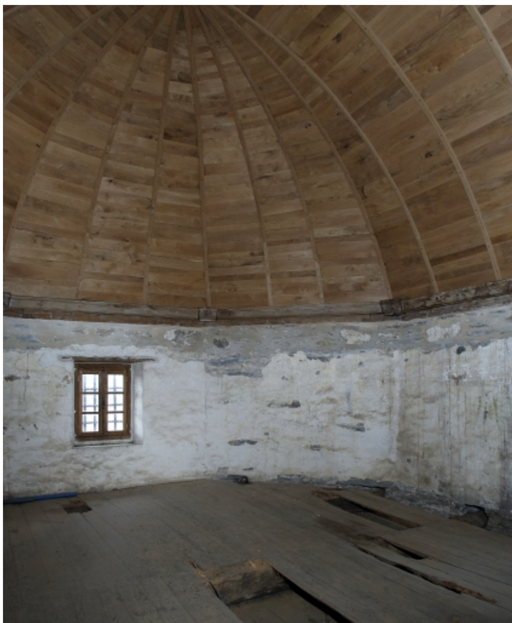
Sacristie, étage : charpente
