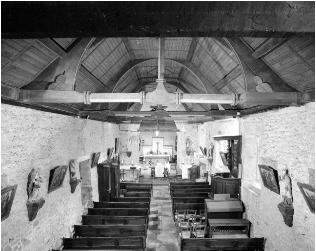
Intérieur : vue générale vers le chœur.
