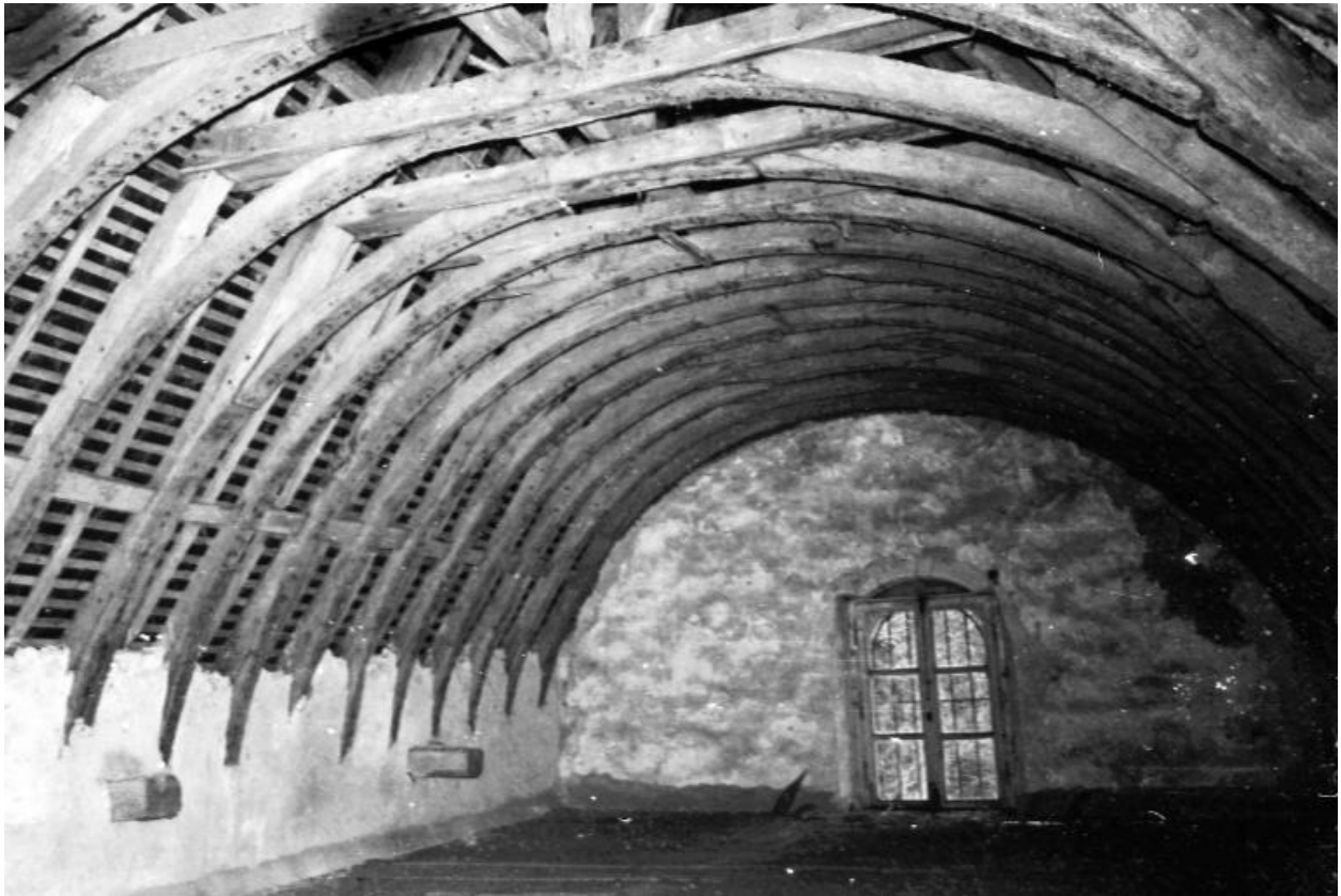
Chapelle, vue générale de la charpente.
