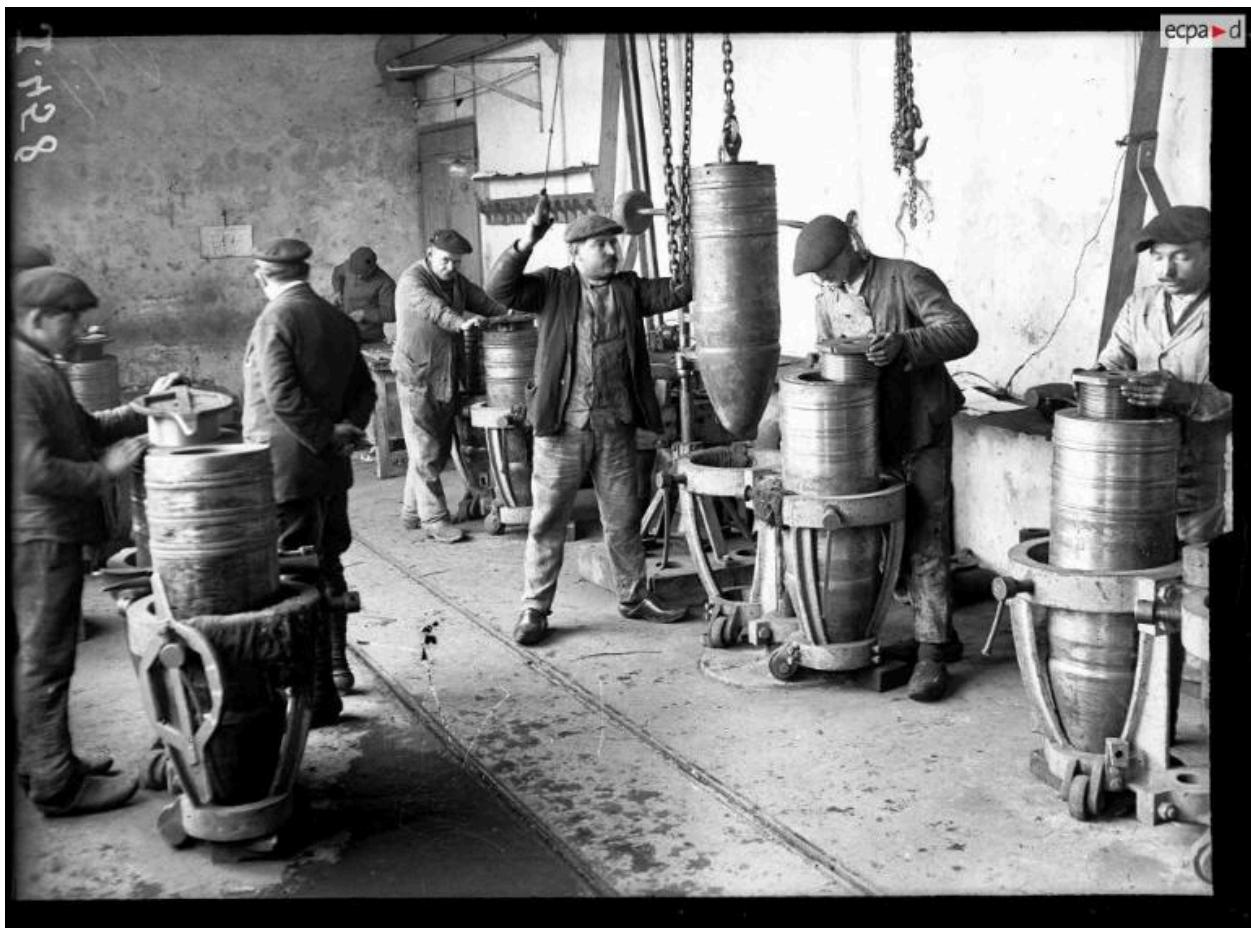
Vue intérieure d'un atelier en 1916 : montage des obus de 340 mm. L'équipe est masculine. Cet atelier, équipé d'un pont roulant manuel, est traversé par une voie ferrée étroite sur laquelle circulent les chariots
