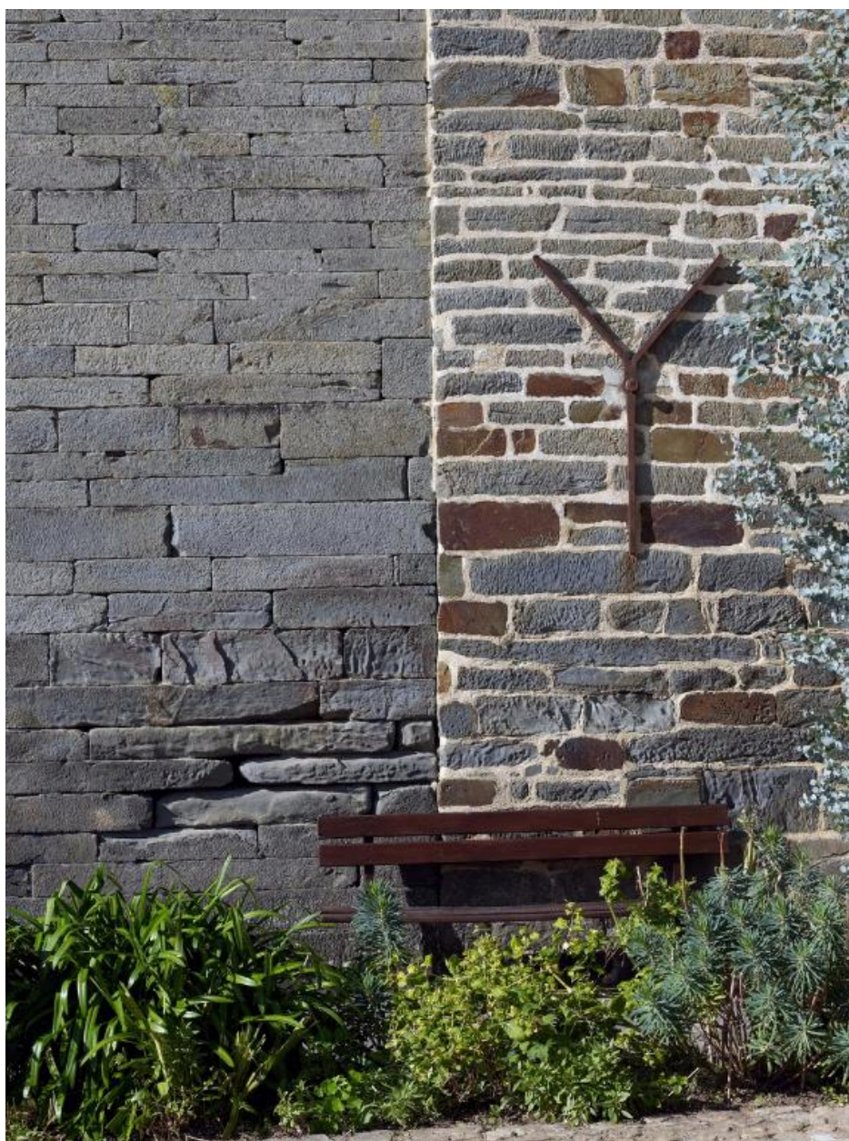
Jonction des murs de la façade sud
