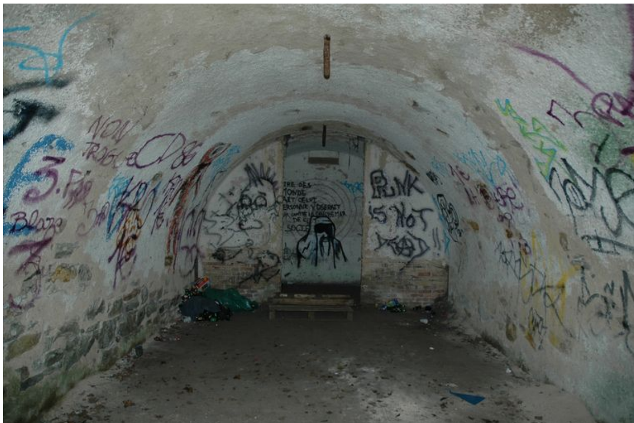
Vue de l'abris à munition est (état en 2005)
