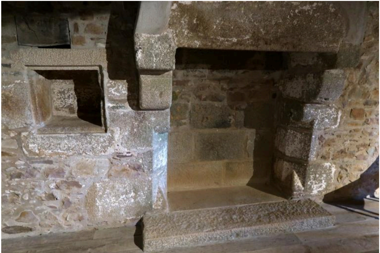
Vue du logement du chapelain : deuxième salle, ensemble cheminée et niche murale
