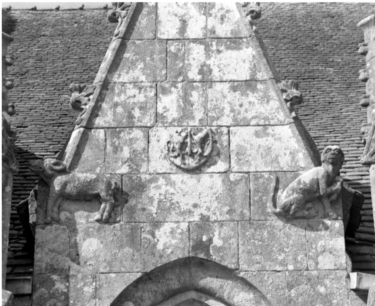
Face sud, partie ouest : écu du gâble est
