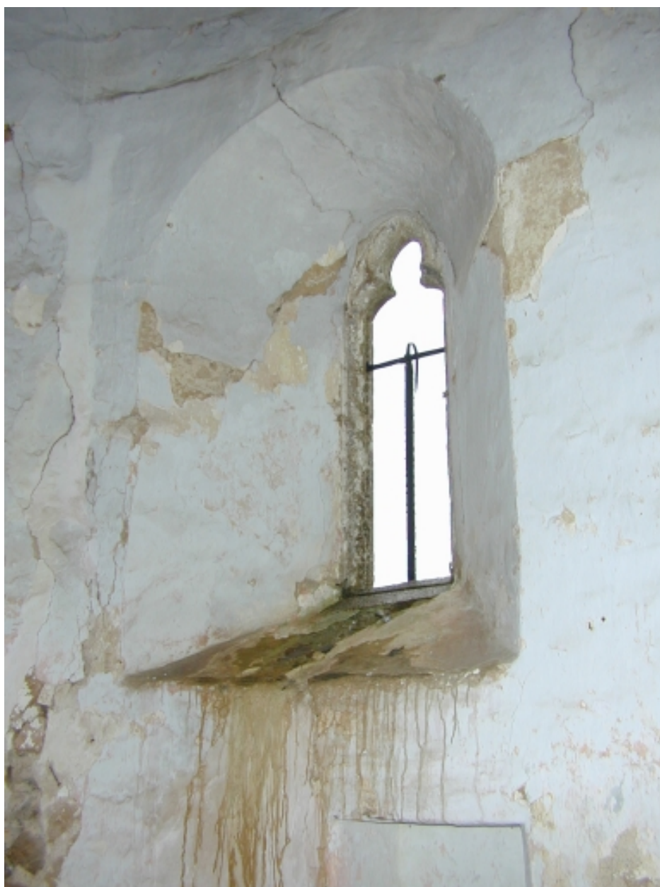
Vue intérieure ; détail
