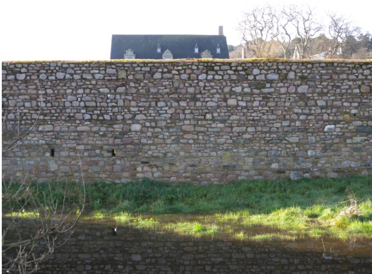
Vue du mur d'enceinte rejointoillé
