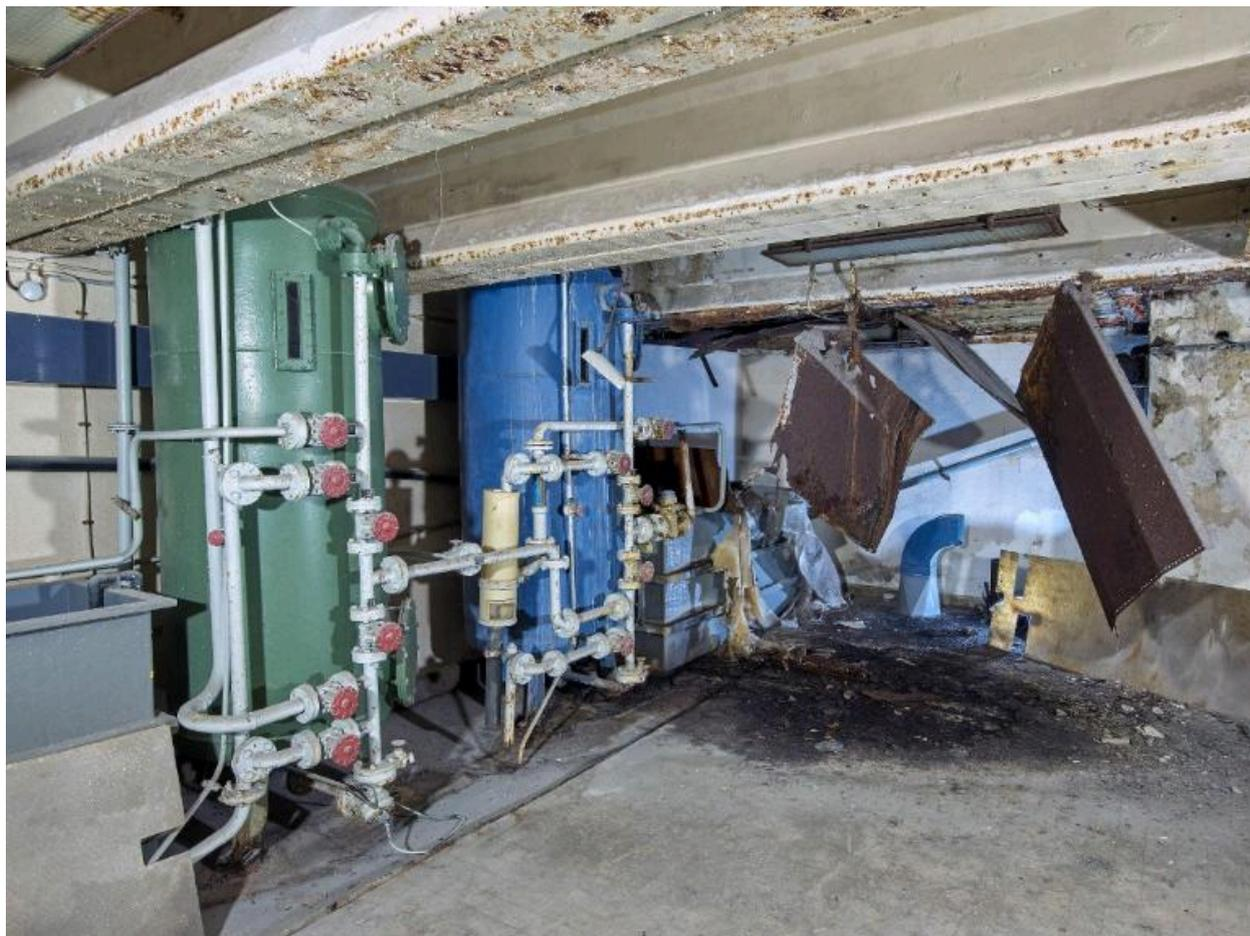
Vue de l'ensemble bacs, chambres et système de tuyauterie. Le plafond est constitué de poutres préfabriquées en béton armé avec avec plafonnier à lampe fluorescente. Le fond de la pièce est dégradée du fait de l'infiltration des eaux pluviales
