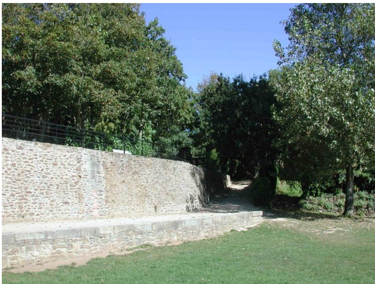
Vue du fort du Dellec : rampe inclinée de la batterie
