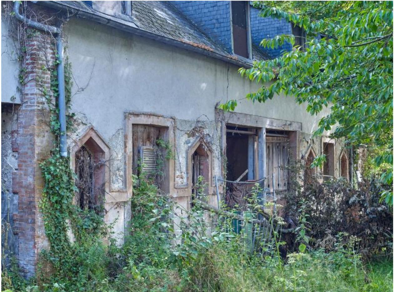
Vue des communs et dépendances : élévation sud. Remise à poteau de bois encadrée par les écuries. A signaler, la forme triangulaire des fenêtres encadrant la porte rectangulaire ; le jeu de couleur entre granite gris, brique et enduits
