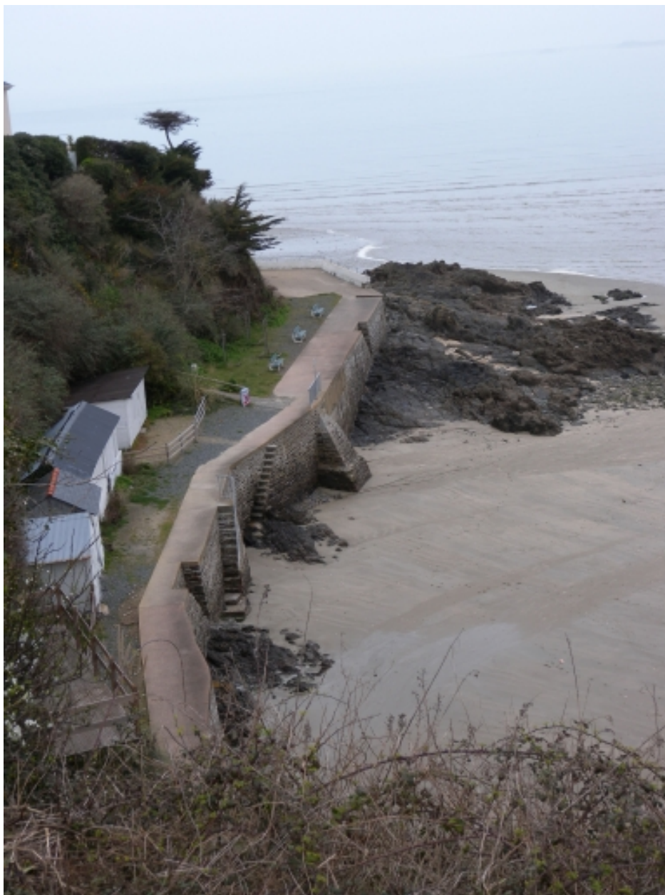
Vue du front de mer de l'anse des Moines, au niveau de la pointe Chatern : la digue-promenade, les escaliers de desserte et les cabines de bains au pied de la falaise
