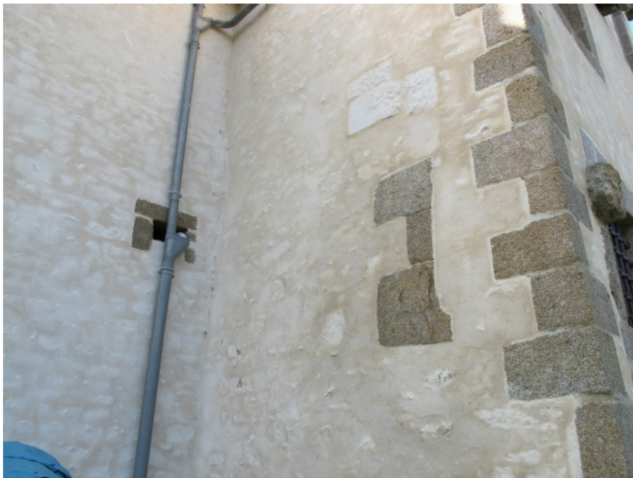
Façade nord du logis
