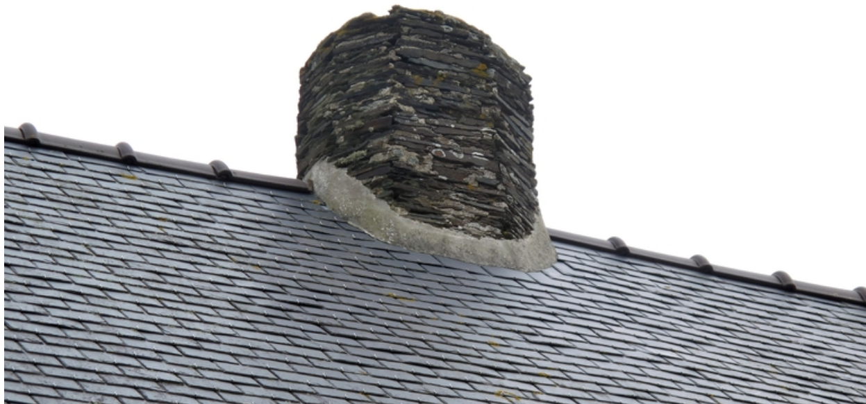
Vue de détail du logis : souche de cheminée de plan octogonal
