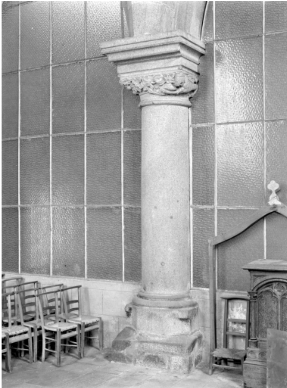
Intérieur, coté Sud, pilier n°1 : vue générale.
