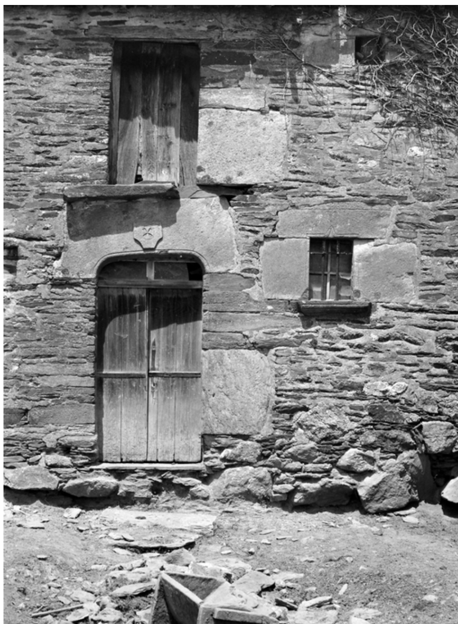
Maison, élévation sud : les baies (état en 1983)
