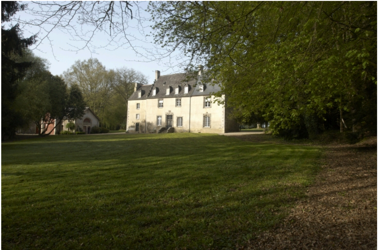
Logis, vue générale
