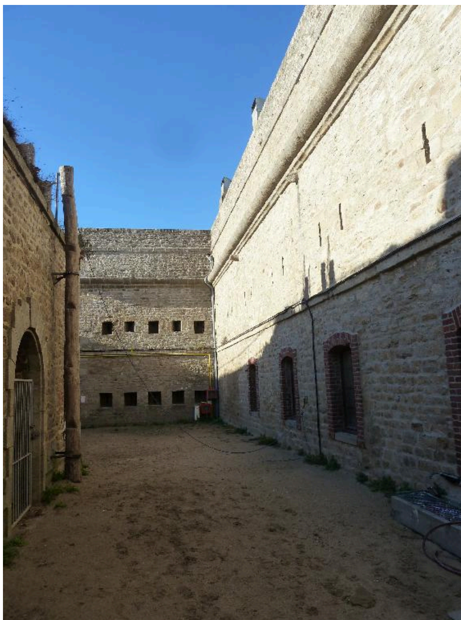
Saint-Pierre-Quiberon, fort de Penthievre, caserne défensive, façade sud-est et fossé.
