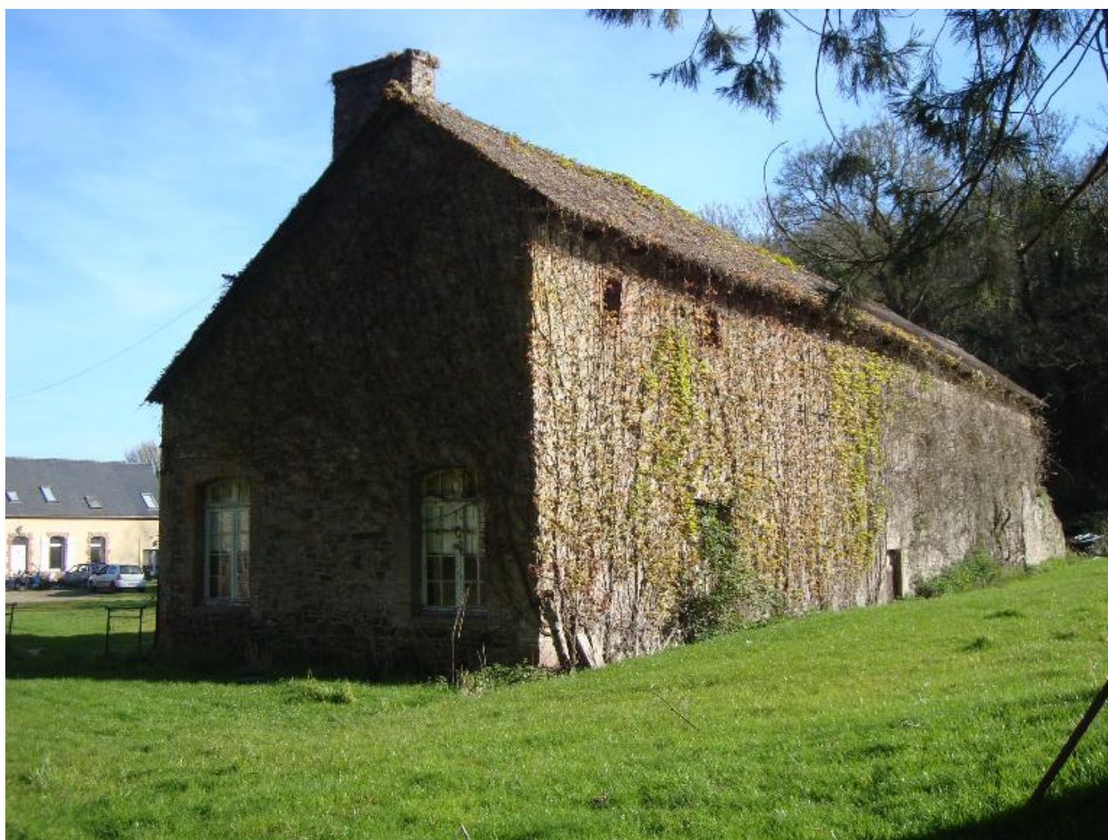
Bâtiment 2 (façade sud-est)
