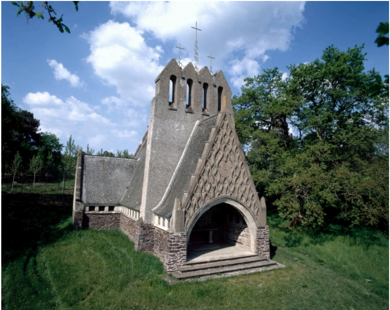
Elévation Nord-Ouest : vue générale
