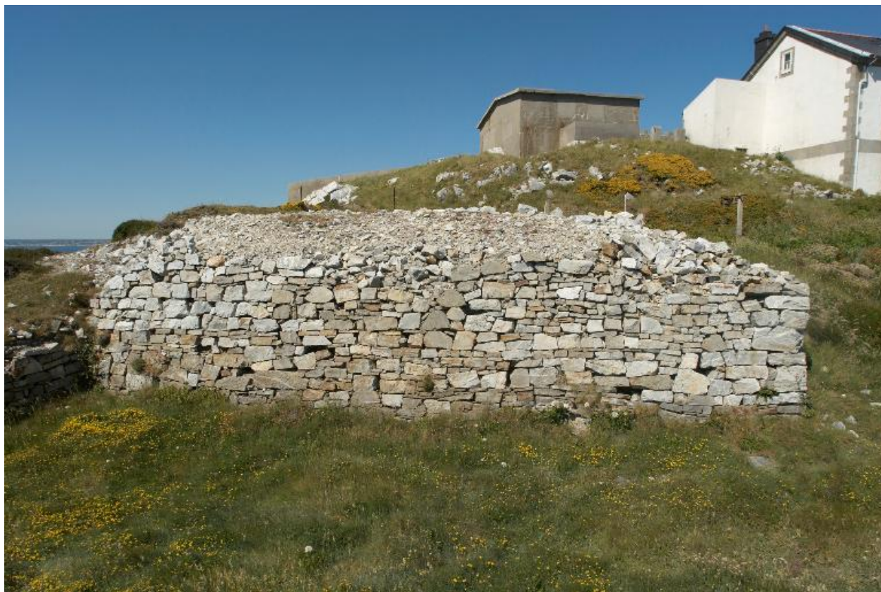
Camaret, pointe du Toulinguet : mur de la batterie de côte
