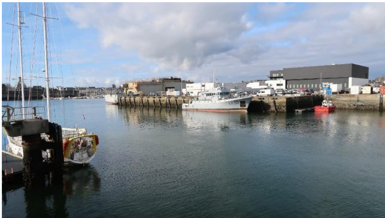
Aire de réparation navale : quai Pétrolier
