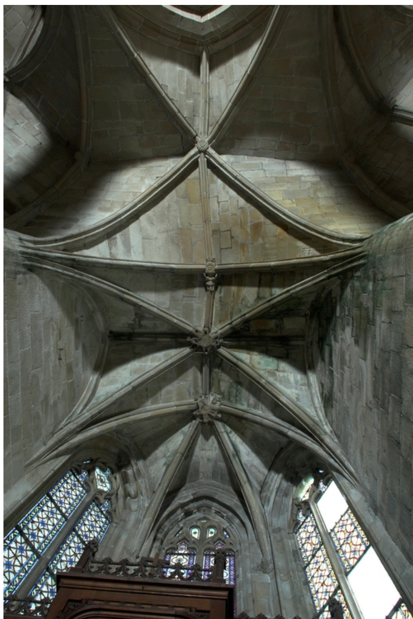
Voûtes du déambulatoire du chœur et de la chapelle d'axe.
