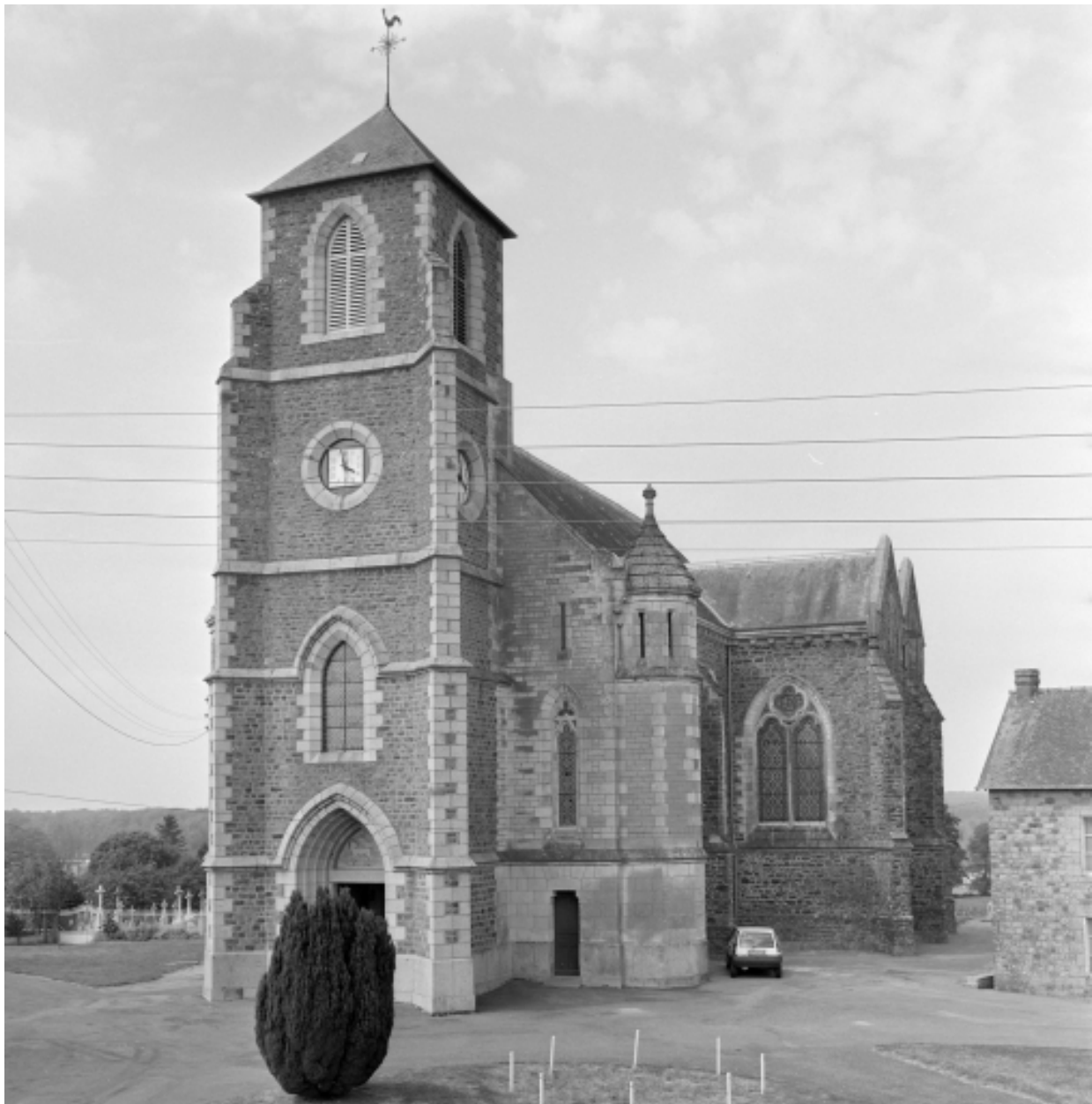
Elévation Sud-Ouest : vue générale
