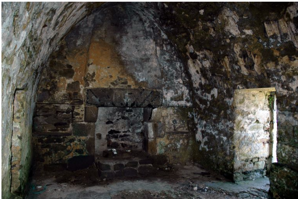
Vue de la cheminée dans le pignon Sud (état en 2004). Elle est encadrée de deux niches murales
