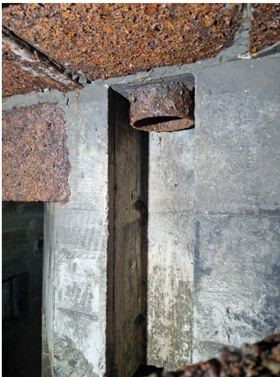
Vue de l'entrée nord : détail du passage d'antenne dans la dalle de couverture
