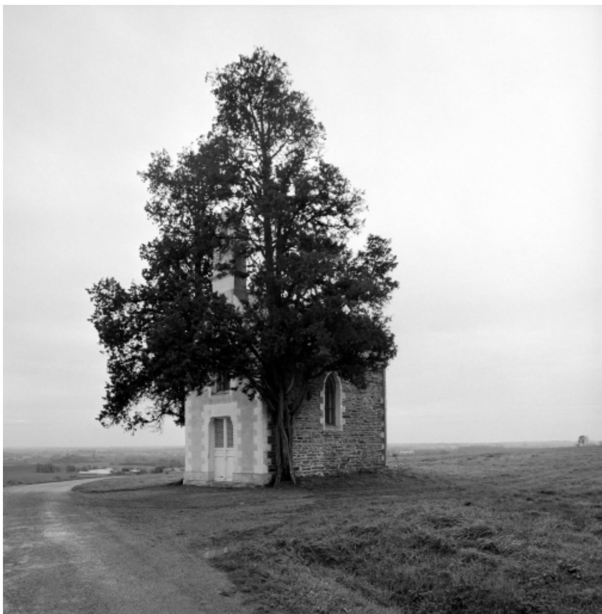
Elévation Ouest : vue de situation
