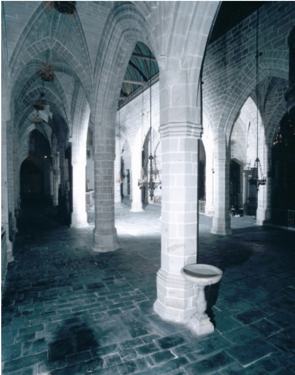
Vue du bas côté nord.
