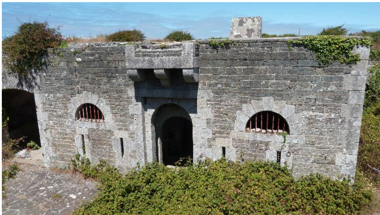
Groix, batterie du Bas-Grognon, corps de garde crénelé, façade.
