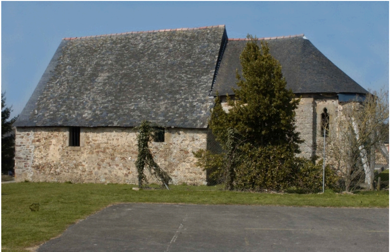
Vue générale sud
