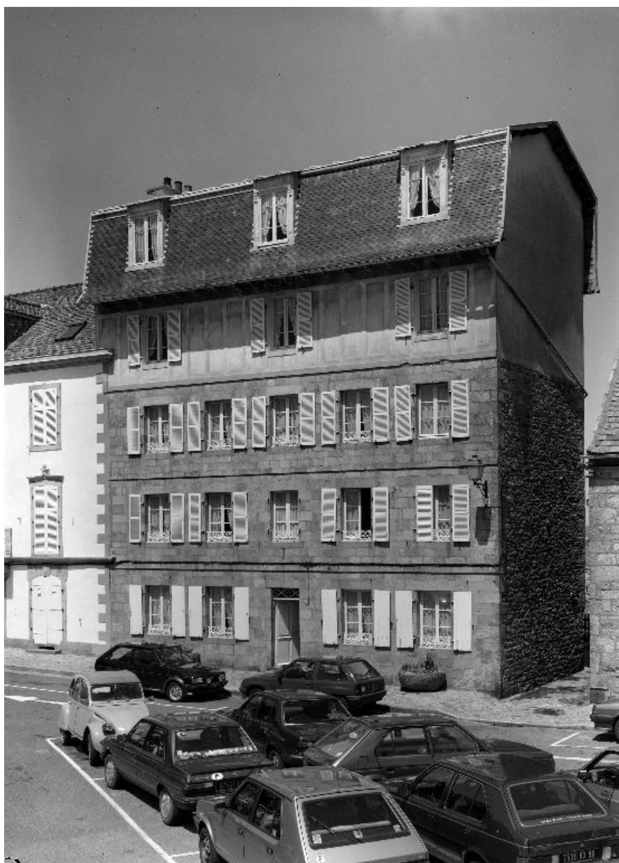
17 place Lacaze-Duthiers, élévation sud, vue générale
