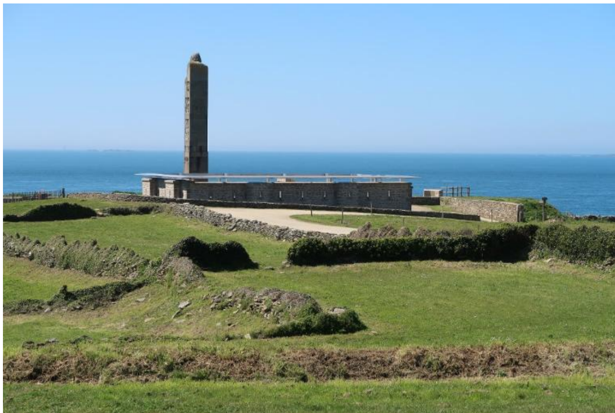
Vue de situation depuis l'est-nord-est
