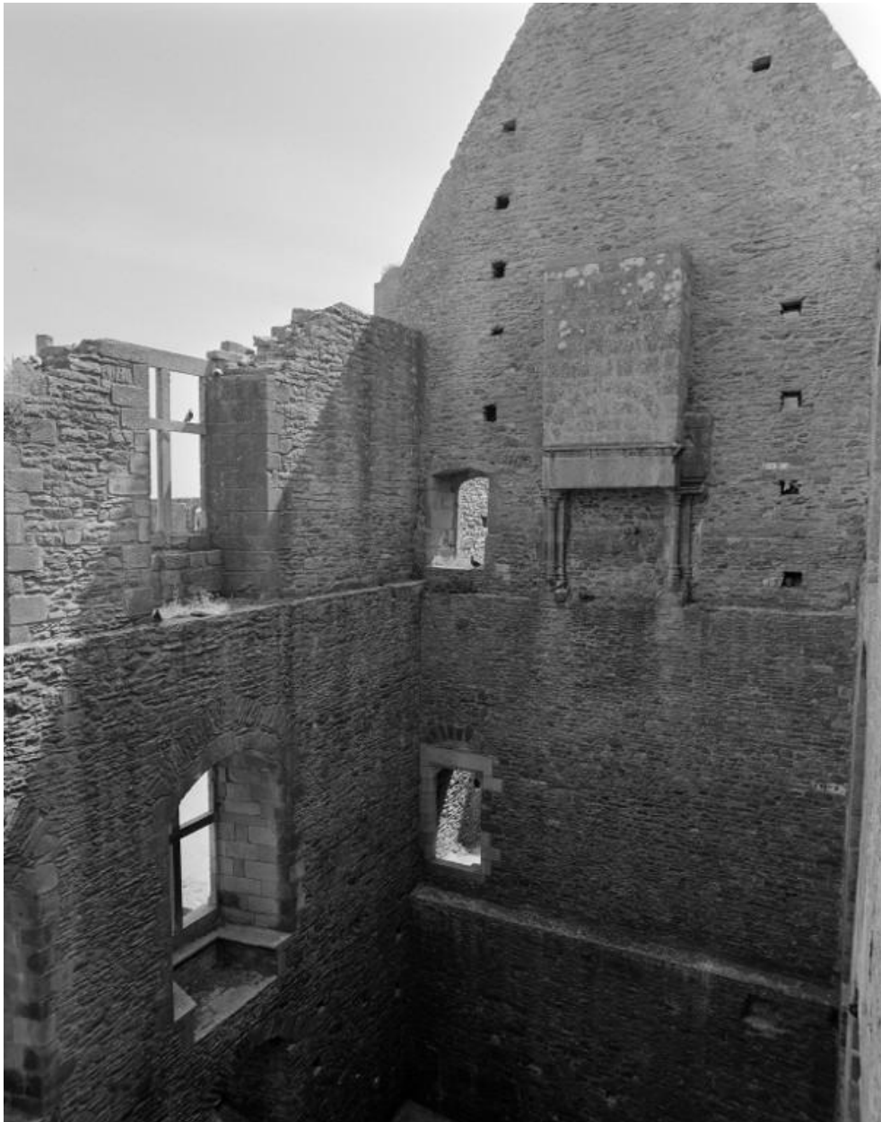
Château fort, logis ouest, deuxième étage, salle, vue vers le sud.
