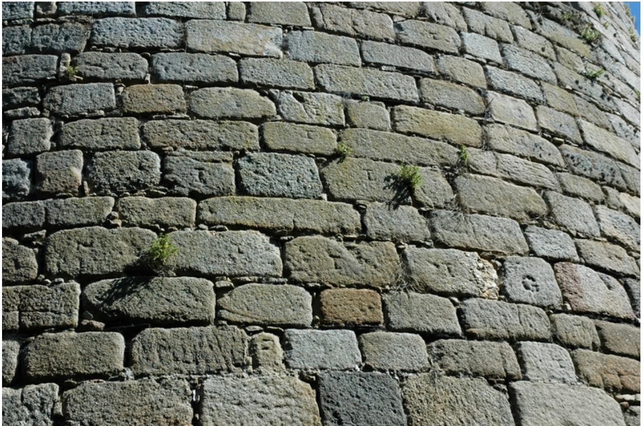
Vue de la tour nord dite dit tour de Rougé : détail de la maçonnerie en pierre de taille de granite montrant des marques de tâcheron
