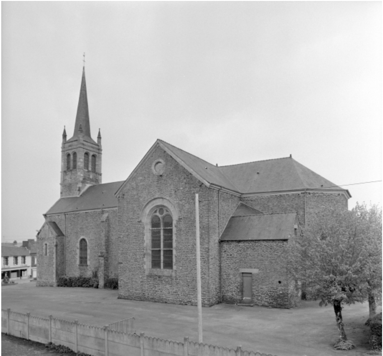
Elévation Ouest : vue générale
