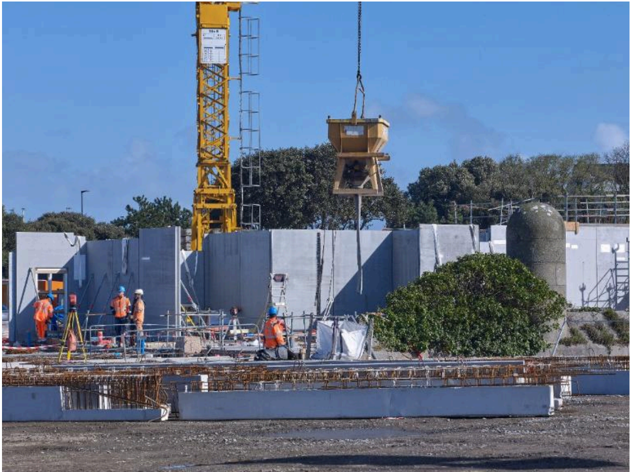
Vue du chantier du terre-plein du Naye (couverture photographique du 11 mars 2026). A droite, la dame du fort du Naye
